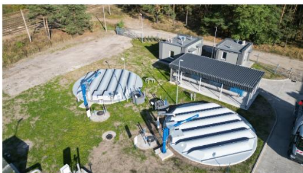
Główna Przepompownia Ścieków w Białych Błotach
