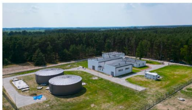
Stacja Uzdatniania wody w Cielu
