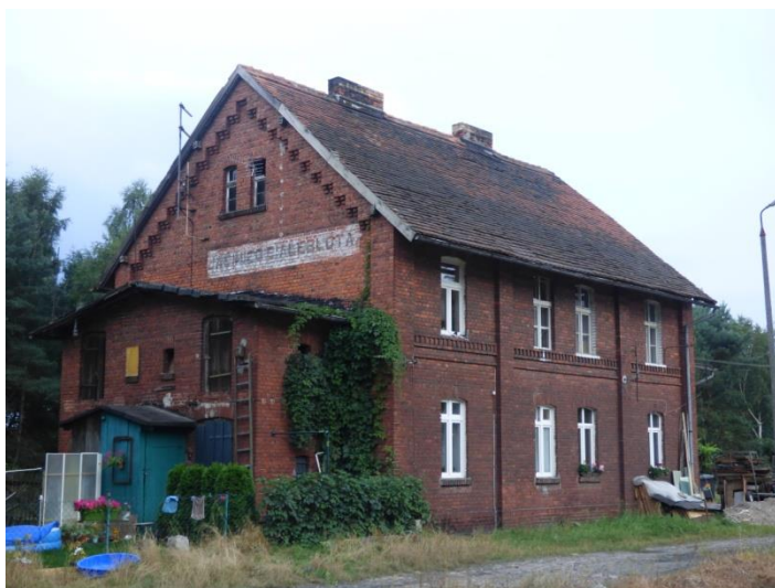
Fot. 13. Dworzec w Jasińcu Stacji, ob. budynek mieszkalny
