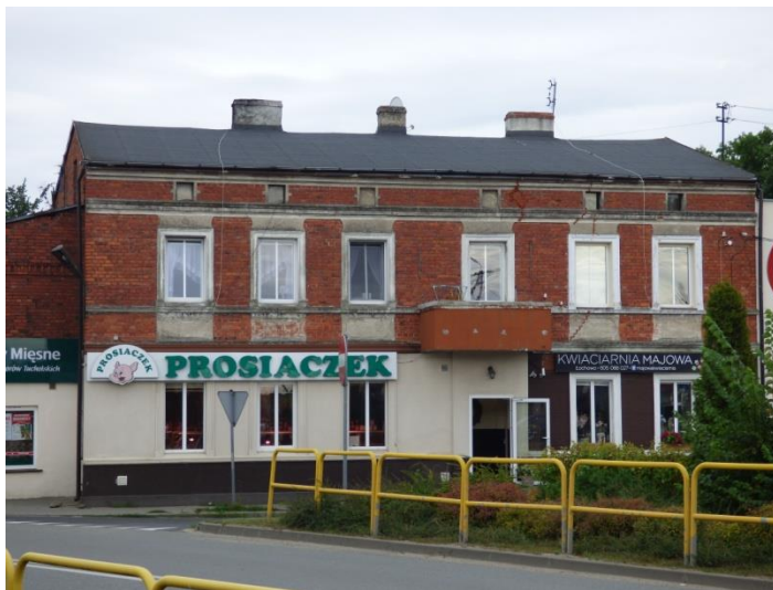
Fot. 10. Dom, ob. budynek mieszkalno-usługowy w Łochowie
