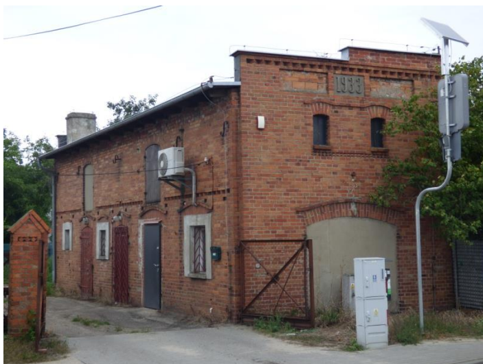
Fot. 11. Budynek gospodarczy przy poczcie w Łochowie
