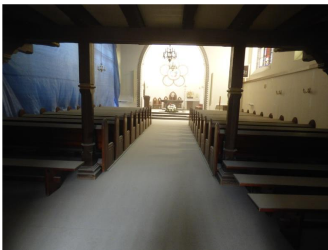
Fot. 1. Wnętrze kościoła w Łochowie (w trakcie prac remontowych)
