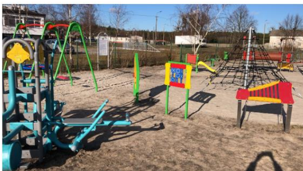
Budowa placu zabaw przy Świetlicy Socjoterapeutycznej
